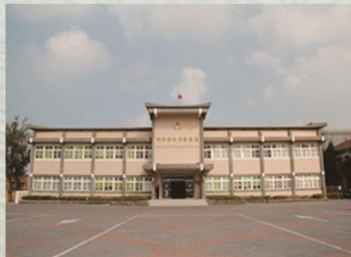
* 民國93年12月間鑑於廳舍老舊，乃重新設計施工，於民國94年2月間竣工，整修後展現警察新形象，令人耳目一新。
