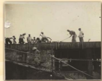
* 興建施工情形
